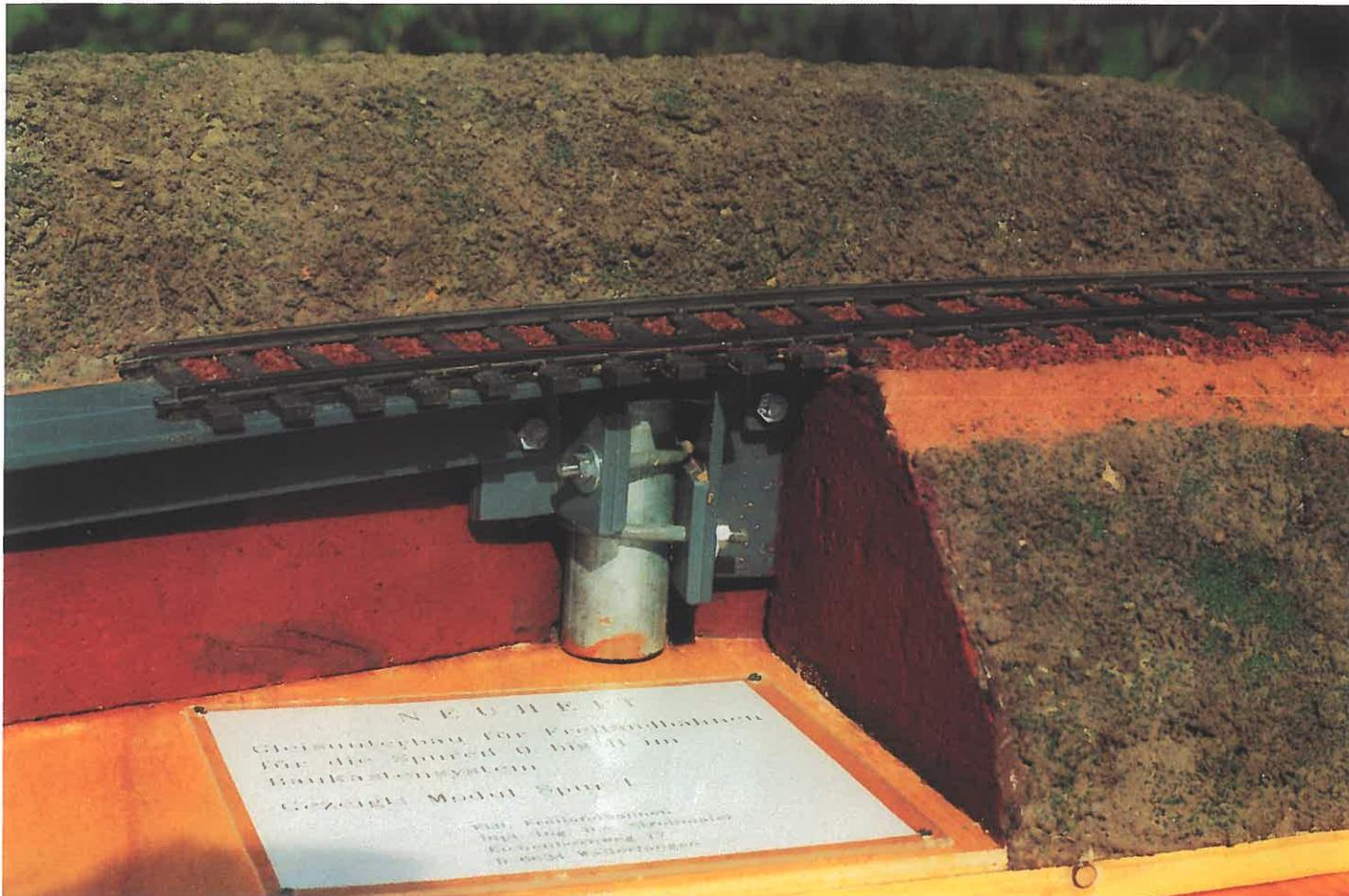
FLB: Das Demonstrationsmodul zeigt den Gleisunterbau und den Anschluß der Tragelemente an einen Pfahl.
